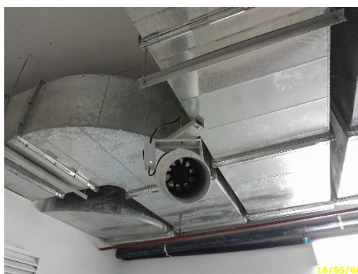
ภาพที่ 2.2-4 ระบบกรองอากาศชั้นจอดรถใต้ดิน อาคาร X
