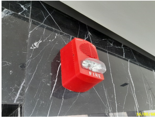
อุปกรณ์แจ้งเหตุด้วยแสง และเสียง
